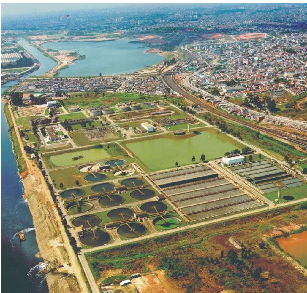
Figura 4 – Vista da ETE Barueri Fonte: Sabesp, Unidade de Negócio Oeste - MO.
